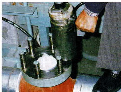
バルブフランジの植込ボルトへ使用中
